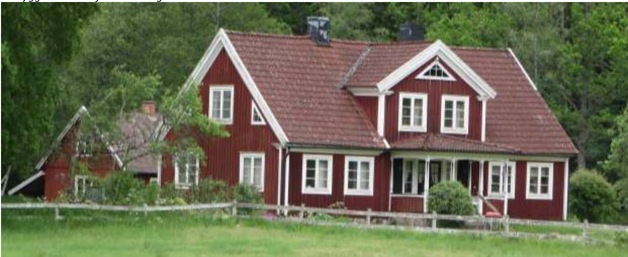
Bostadshuset på Ekeboryd 1:4 är en välbevarad salsbyggnad. Till gårdsmiljön hör även sidobyggnad och trädgård.
