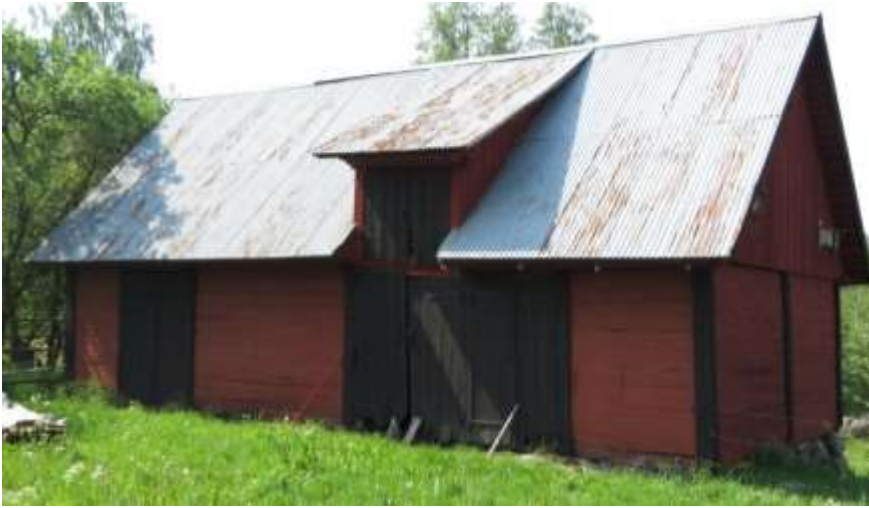
Detta lilla uthus byggt i skiftesverk är idag den enda byggnad som ligger kvar i gamla bykärnan (Enkoneryd 1:2).
