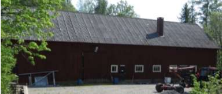
Ladugården som hör till är uppförd 1952 (Enkoneryd 1:9).
