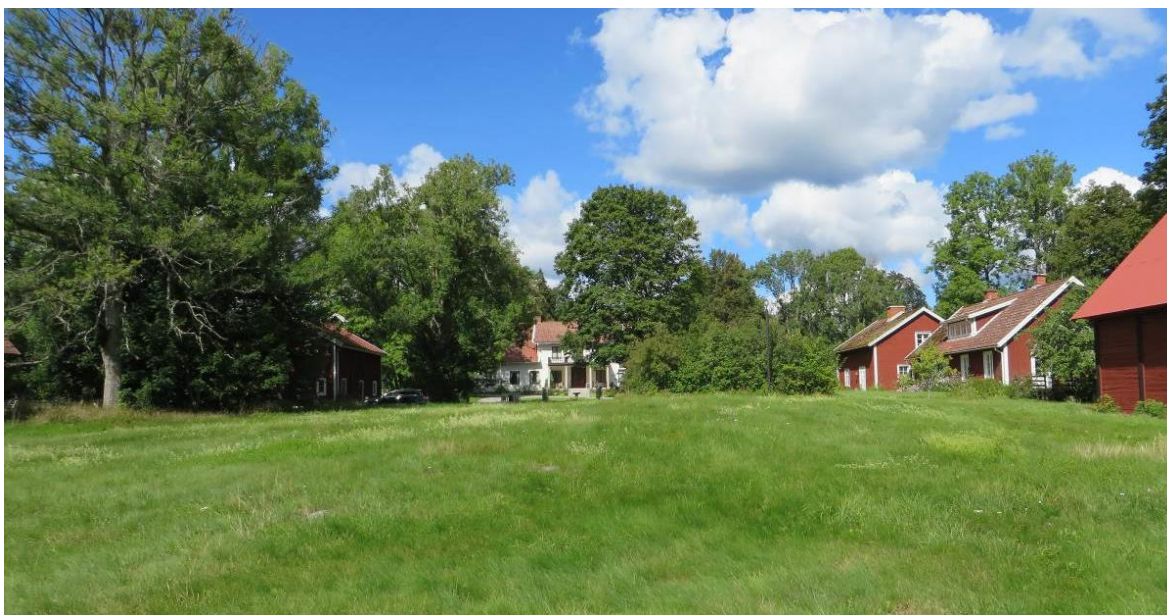
Gårdsbebyggelsen sedd från gårdsplanen i söder. Huvudbyggnaden ses i mitten flankerad av magasinet och lada (utanför bild) till vänster samt mejeri, arrendatorsbostad och lada i följd till höger.
