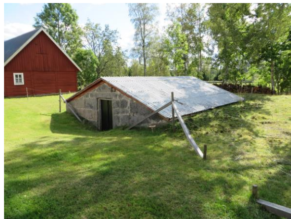
Stenkällare i anslutning till ekonomibyggnaderna.
