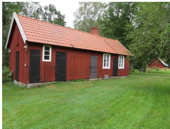
Ett av de två uthusen/bryggghuens.
