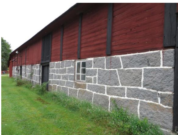
Den västra ladugården i Harebokvarn är byggd av sten.
