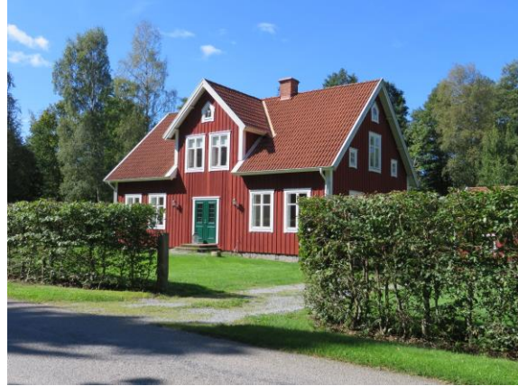
Ingemundebo 2:19 norr om bykärnan, mangårdsbyggnad från ca 1900.
