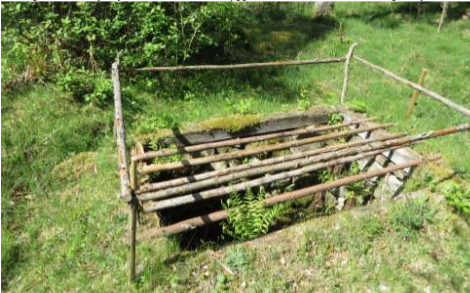
Den bevarade stensatta gropen som användes för torkning av lin (räcket runt är ett sentida skydd)
