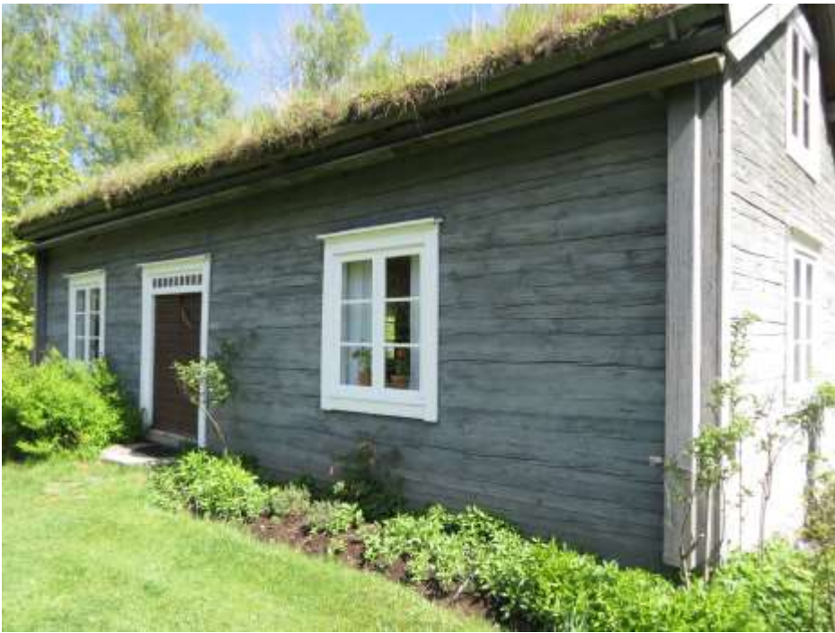
Torpet har ursprungliga byggnadsdetaljer som dörrar och fönster.
