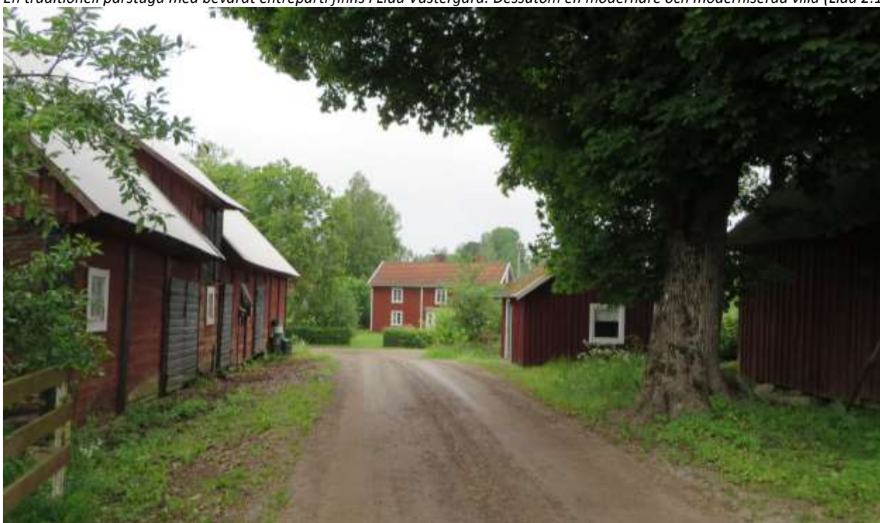
De gamla ladugårdarna på var sida den lilla grusvägen ger karaktär åt Lida Västergård. (Ladan väster om vägen på Lida 2:9 och öster om vägen på två fastigheter: Lida 2:15 och 2:20) Det gamla ishuset/posthuset ligger också här (Lida 2:15).
