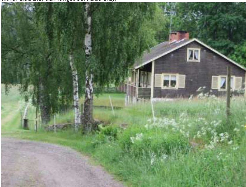
En av få under 1900-talet nyuppförda bostadhus i bymiljöerna i Långsjö socken som byggts och bevarats i tidstypisk stil (Lida 3:1).
