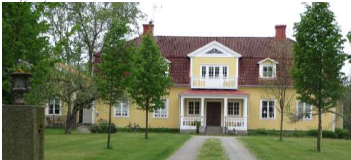
Prästgården har ett klassicistiskt utseende. Byggnaden (1920-tal?) är större än vanliga gårdar, målad med (ursprungligen) dyrare oljefärg (i stället för rödfärg) och påkostad trädgård. Symmetri och pompighet utmärker byggnaden än idag. Den första prästgården låg precis norr om den nuvarande, sedan slutet av 1600-talet (se karta ovan). Den användes sedan som arrendatorsbostad.
