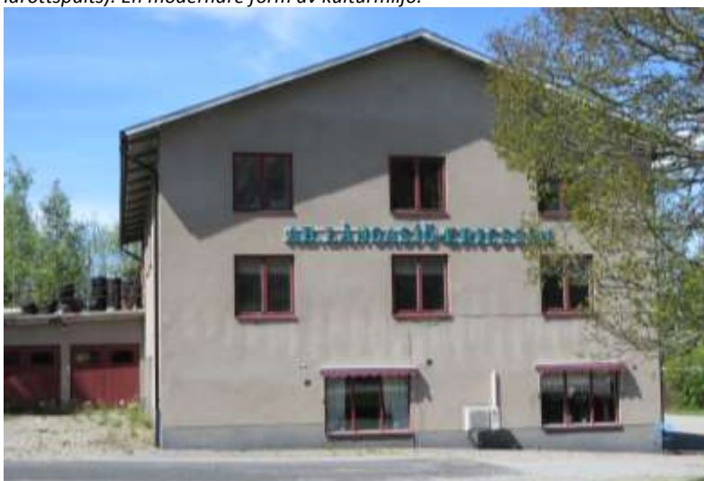
Långasjö-Erikssons verkstadsbyggand har originaldelar och detaljer som den putsade fasaden, fönster och portar.
