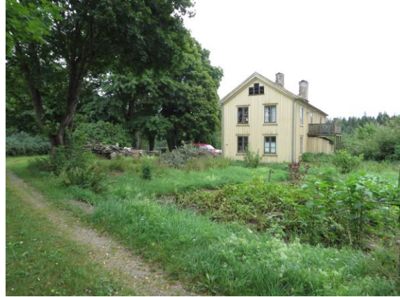
Mundekulla1:2, mangårdsbyggnaden. Detta bostadshus ligger högst i byn och är det enda som är oljefärgsmålrat.
