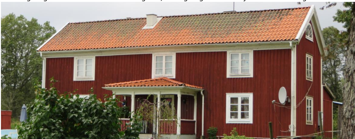
En av de utskiftade gårdarna sydväst om byn har en välbevarad mangårdsbyggnad och två ålderdomliga och välbevarade uthus (Plaggebo 1:4).
