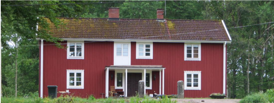
En av de utskiftade gårdarna (Plaggebo 2:5) väster om byn. Hustypen parstuga i två våningar. Här med originalfönster och ytterdörr.
