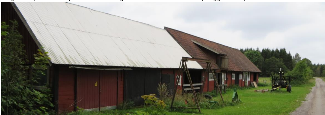
Ladugården är traditionellt byggd i skiftesverk, och ligger på andra sidan vägen. Den har betydelse för rumsbildningen på gården (Plaggebo 1:4).
