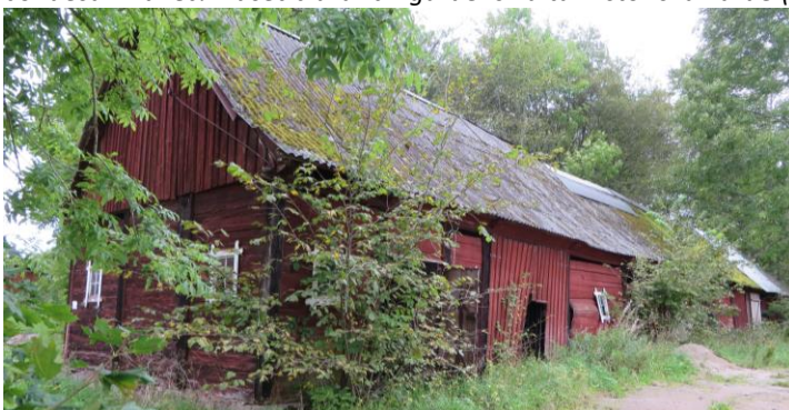
Gårdens ladugård är byggd i skiftesverk på traditionellt sätt, och är kulturhistoriskt viktig i byn (Plaggebo 2:4).
