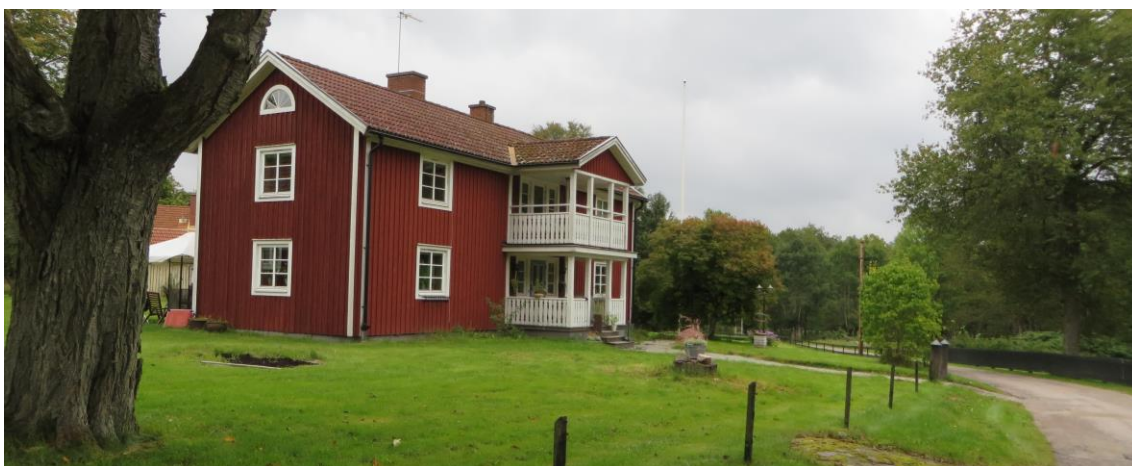
En av de två mangårdsbyggnaderna på Södergård. Även denna parstuga i två våningar med bevarad färgskala men bytta detaljer som fönster, takmaterial mm. Den tillkomna verandan i två våningar kan ses som en årsring från vår tid (Plaggebo 1:9).
