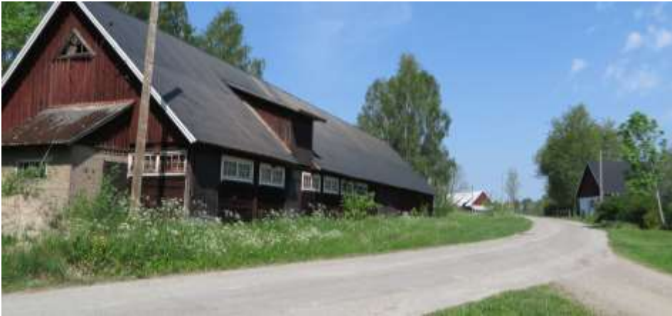
Denna ladugård från 1900-talet (Rammsjö 2:17) ligger i samma läge som ekonomibyggnader på 1820-talet. Tillhör den gamla bykärnan. Landsvägen går mellan bostadshus och ladugård.
