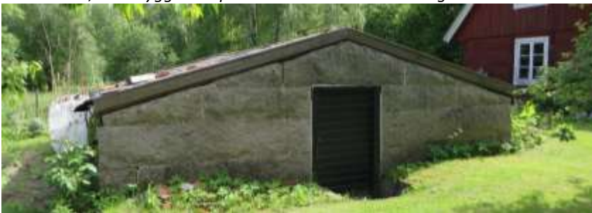
Stenkällare, troligen från 1900-talet (Rammsjö 1:5).
