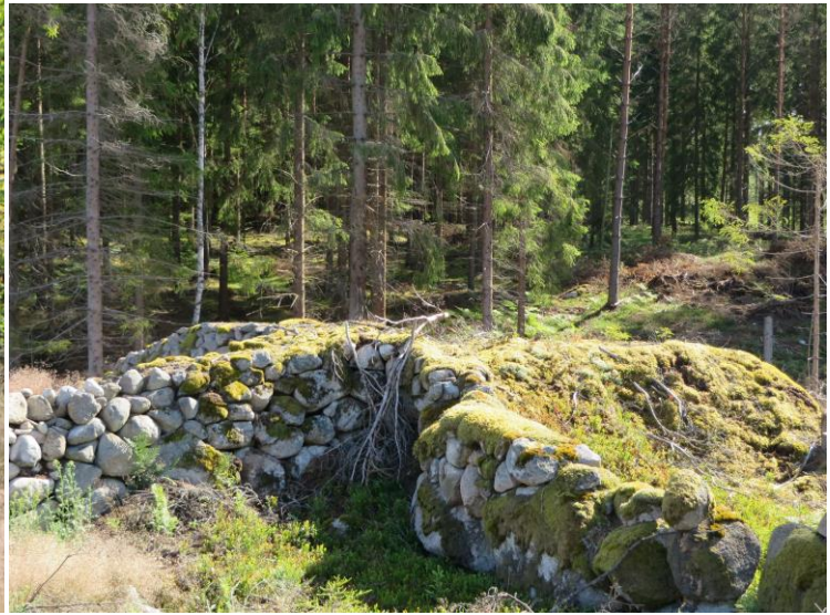
Stenmurar på utägorna i skogen hade till syfte att hålla fåren instängda. Terrängen med berg i dagen gjorde det svårt att sätta stolpar och trögärdesgård eller staket.
