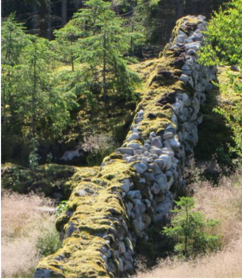
Stenmurar på utägorna i skogen hade till syfte att hålla fåren instängda. Terrängen med berg i dagen gjorde det svårt att sätta stolpar och trögärdesgård eller staket.
