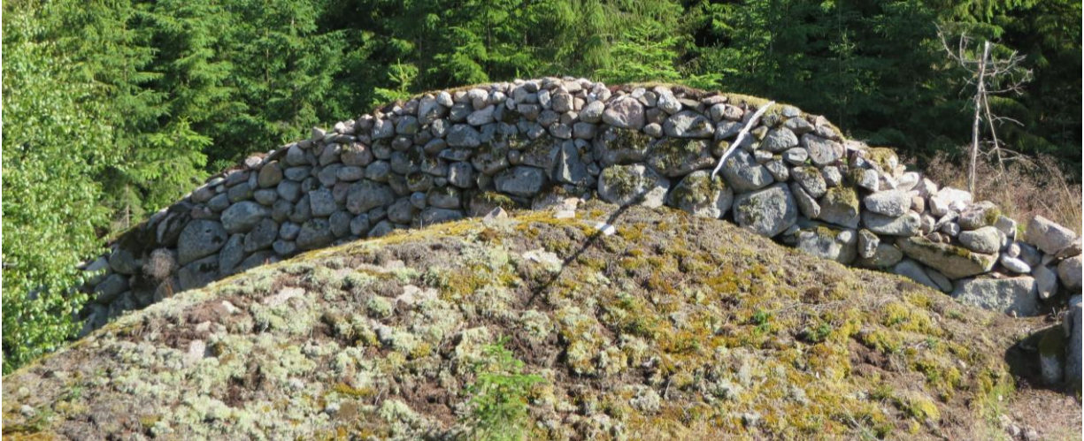
Stenmurar på utägorna i skogen hade till syfte att hålla fåren instängda. Terrängen med berg i dagen gjorde det svårt att sätta stolpar och trögärdesgård eller staket.
