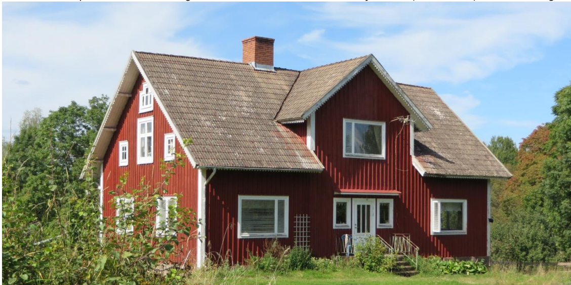
En av byns mangårdsbyggander av salstyp, med frontespis. Originalfönstren finns kvar i gavelpartiet (Skurebo 2:12).
