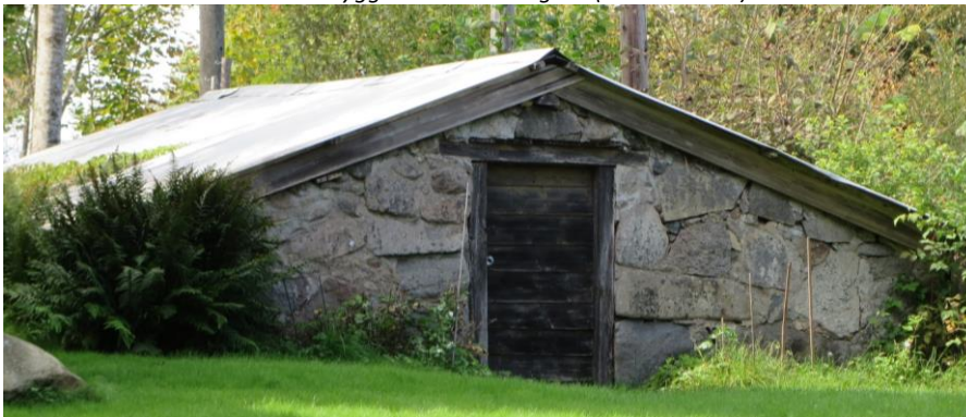
Stenkällare har generallt högt kulturhistoriskt värde (Skurebo 2:10).
