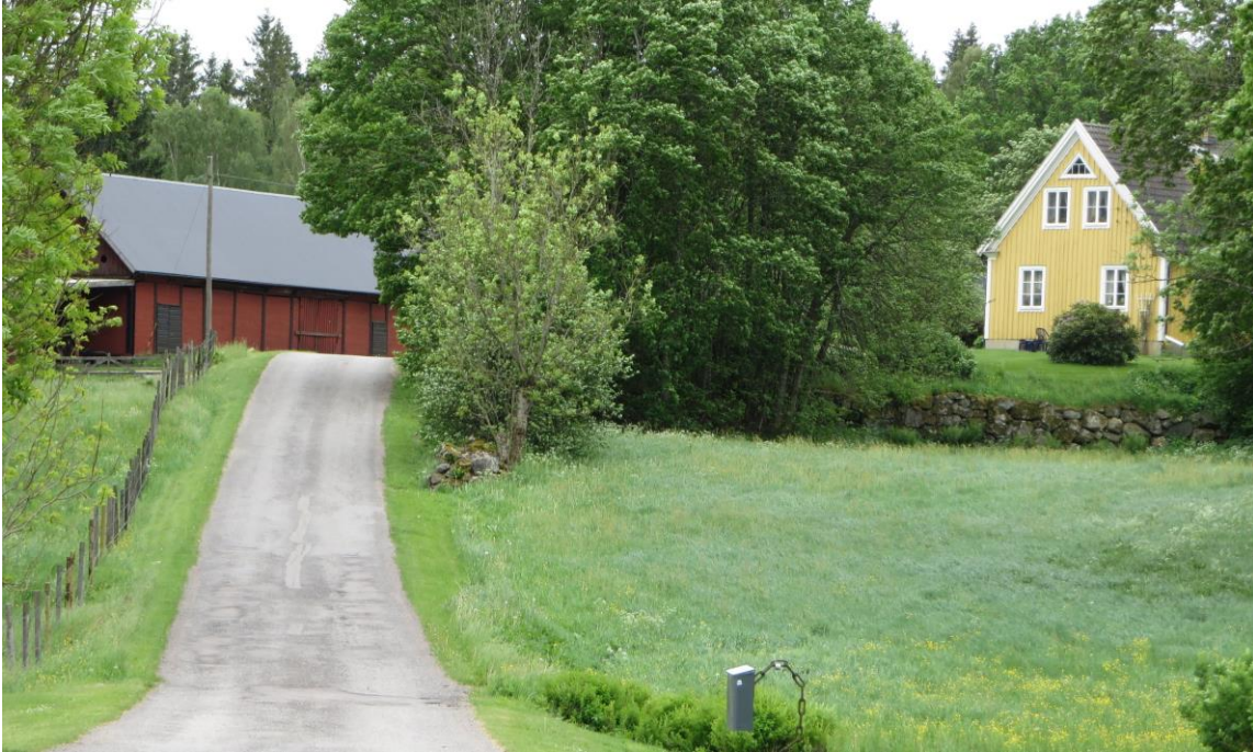
Traditionell ladugård i skiftesverk och bostadshus med oljemålad panel (Strängsmåla 1:4).
