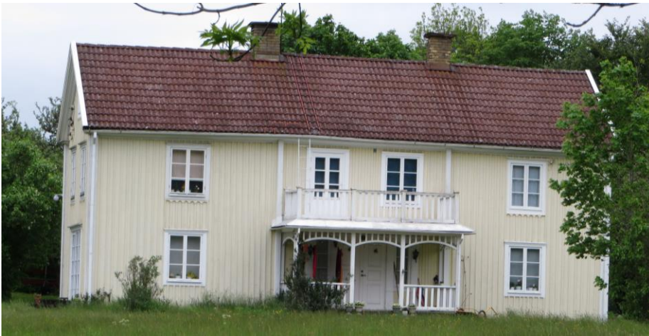
Mangårdsbyggnad med hyvlad ljus träpanel (Strängsmåla 1:24).
