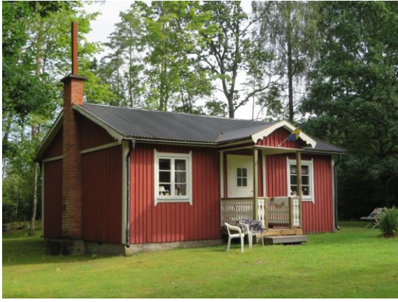
På en av torpet Almebergs f.d. åkrar byggdes en sommarstuga på 1970-talet.
