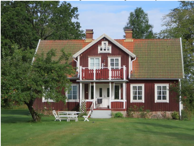
En klassisk småländsk salsbyggnad från andra halvan av 1800-talet (Trollamåla 1:4). Panel, grund, tegeltak och det lilla fönstret i frontespisen är original medan övriga fönster, dörr, veranda bytts ut mot mer moderna.
