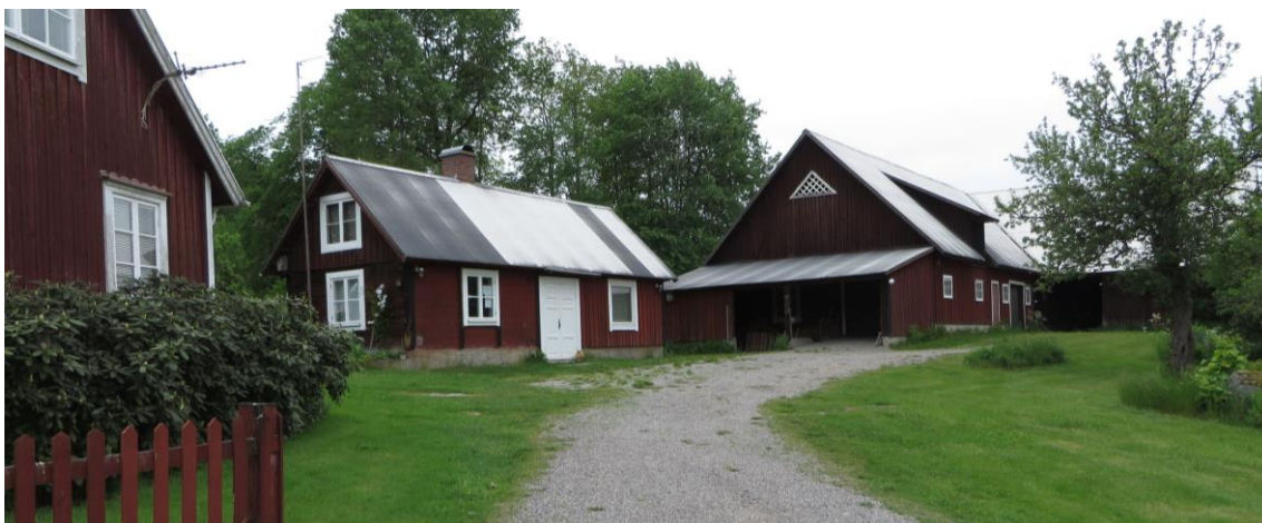
Ladugård och andra ekonomibyggnader (Trollamåla 2:5 ).
