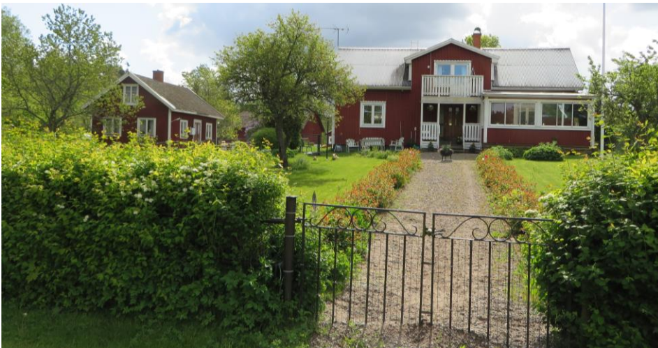
Ombyggd äldre mangårdsbyggnad (1868), med fd undantagshus och ladugård (1946) (Båldön 1:9).
