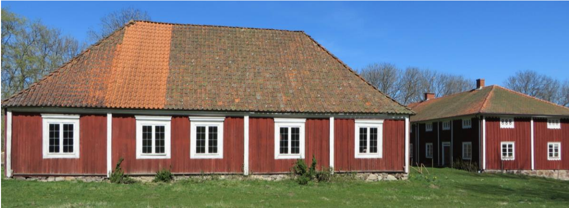
Den gamla huvudbyggnaden från söder, samt östra flygelbyggnaden.
