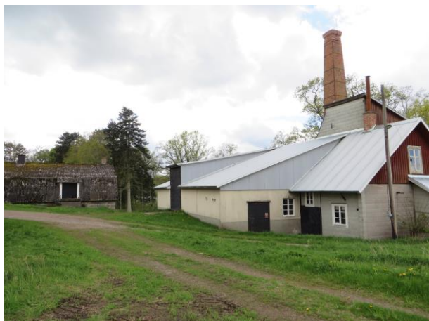
I bränneribyggnaden finns all utrustning kvar. Till vänster ses "mältan".
