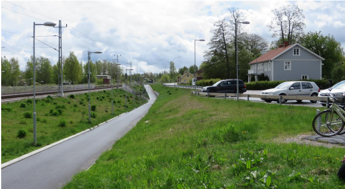
Mitt i bilden låg tidigare Vissefjärdas stationshus. Till höger ses Södra Målatorps mangårdsbyggnad, Södra Målatorp 1:85.
