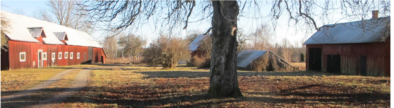
Hultet, idag en ålderdomlig gård med olika uthus och ekonomibyggnader för olika funktioner, t ex stenkällare (Moshultamåla 1:10).
