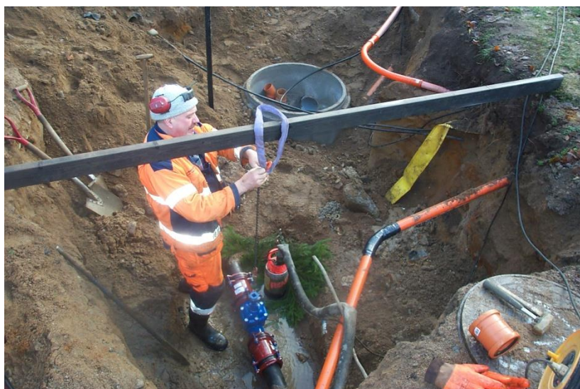
Arbete med VA-ledningar
