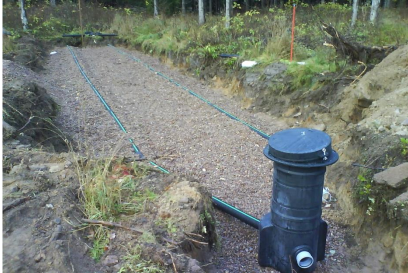
Anläggande av enskild avloppsanläggning med infiltration i mark
